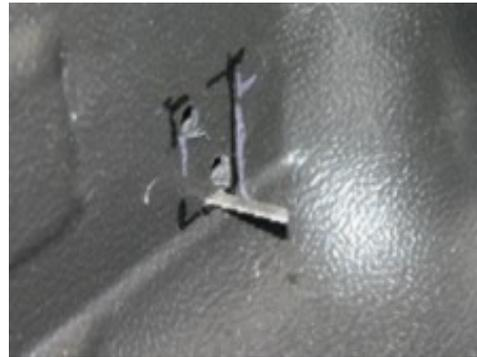
Schneiden Sie die Aussparungen für die Befestigungswinkel der seitlichen System-schienen mit der Stichsäge aus.
